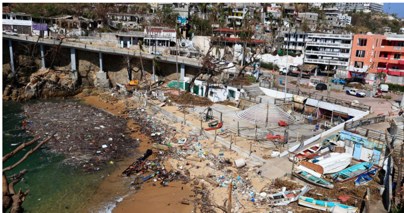
Vista del 30 de octubre de 2023, de los daños causados por el paso del huracán Otis, en Acapulco, estado de Guerrero (México). | Foto: EFE/David Guzmán
